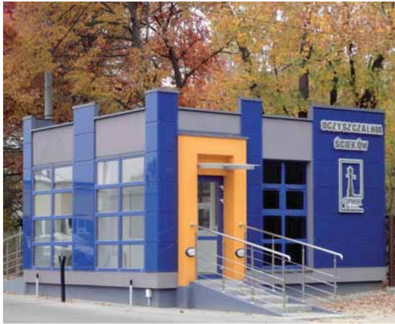
Oczyszczalnia ścieków w Otwocku
